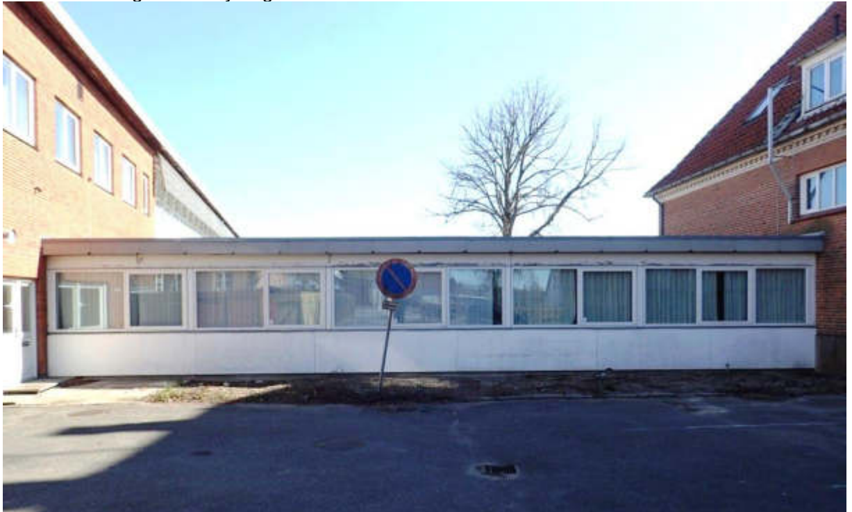
Figur 1 Mellembygning med kontorer set fra vest /vejen.
