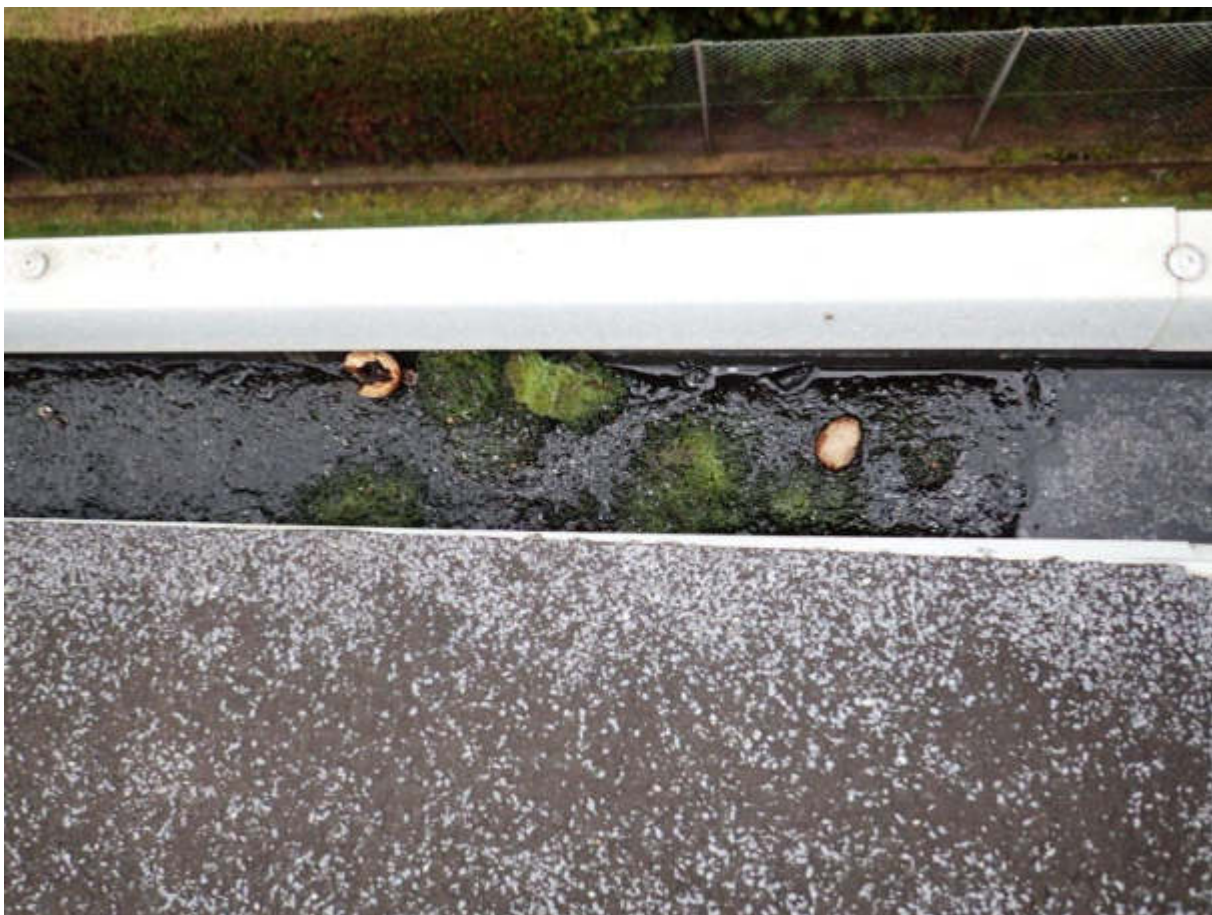
Figur 71 Taget. Flere steder var tagrender delvist fyldt med skidt, mos o.l.
