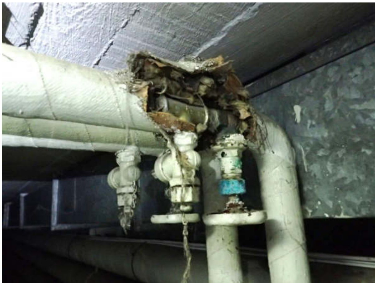
Figur 27 Kælderen. Varmeisolering på installation med skade.
