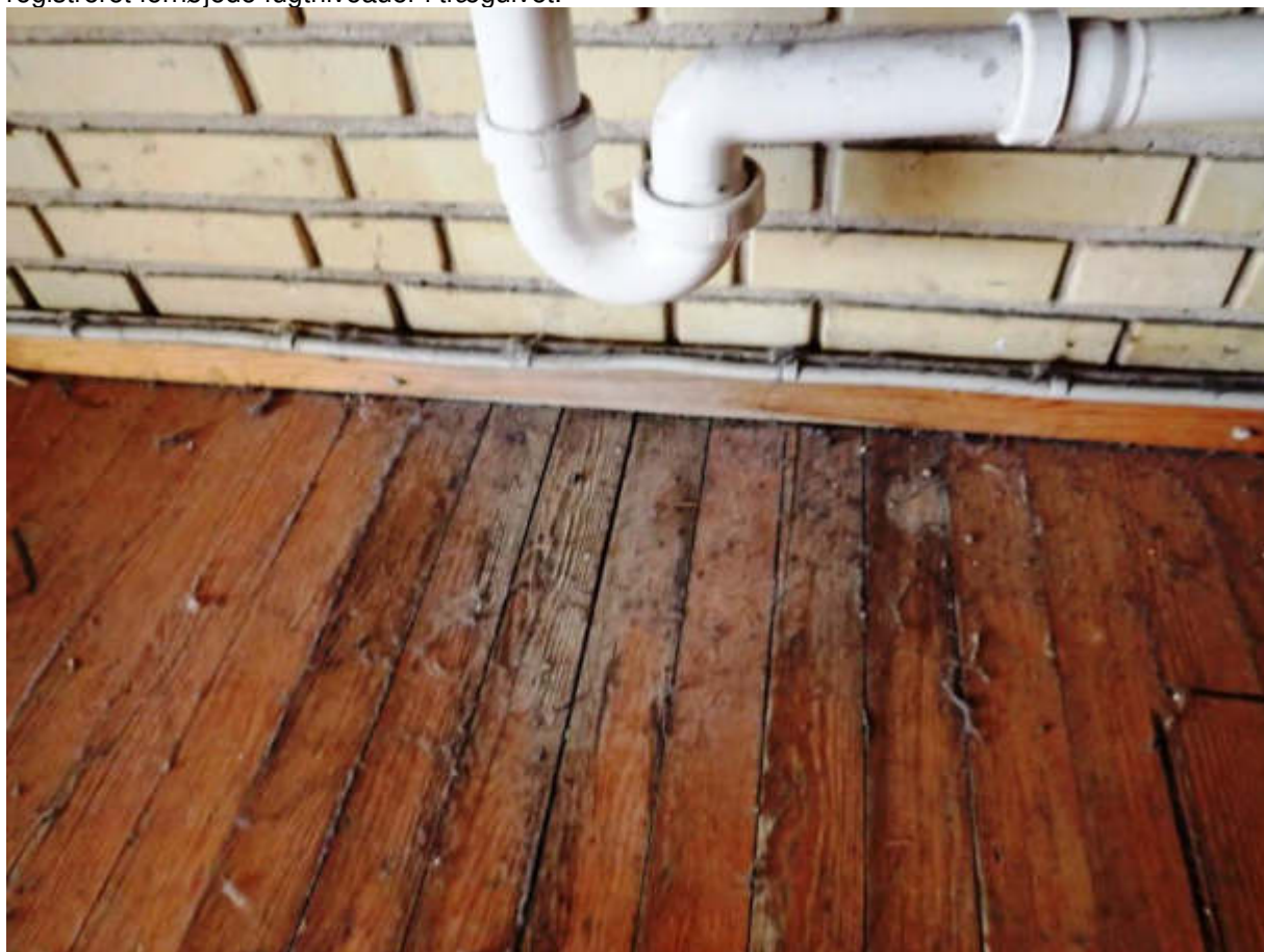
Figur 33 Depotrum ved gymnastiksalen med køkken. Slidt trægulv med skade. Der blev dog ikke registreret forhøjede fugtniveauer i trægulvet.
