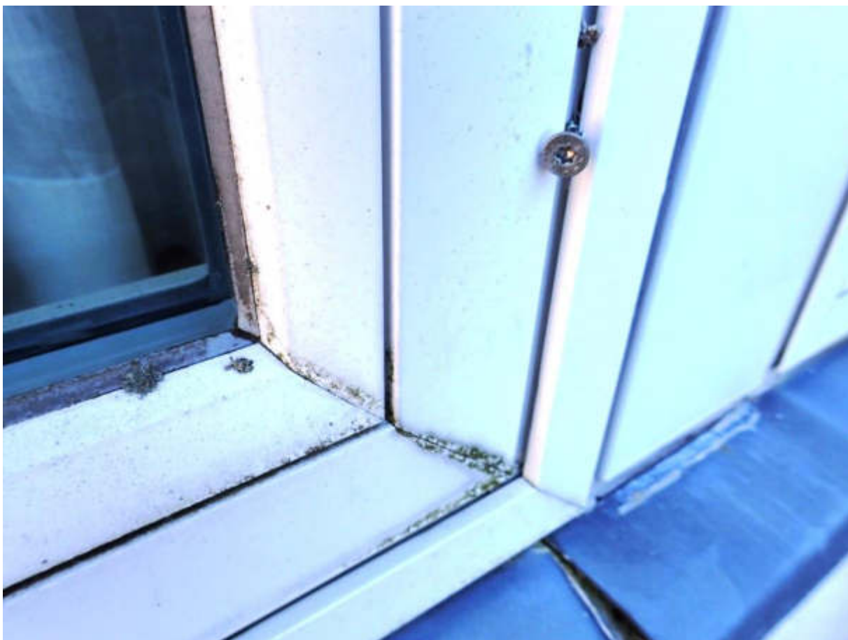
Figur 6 Mellemlbygning med kontorer. Facade mod vest. Vindue af nyere dato blokeret med skrue.
