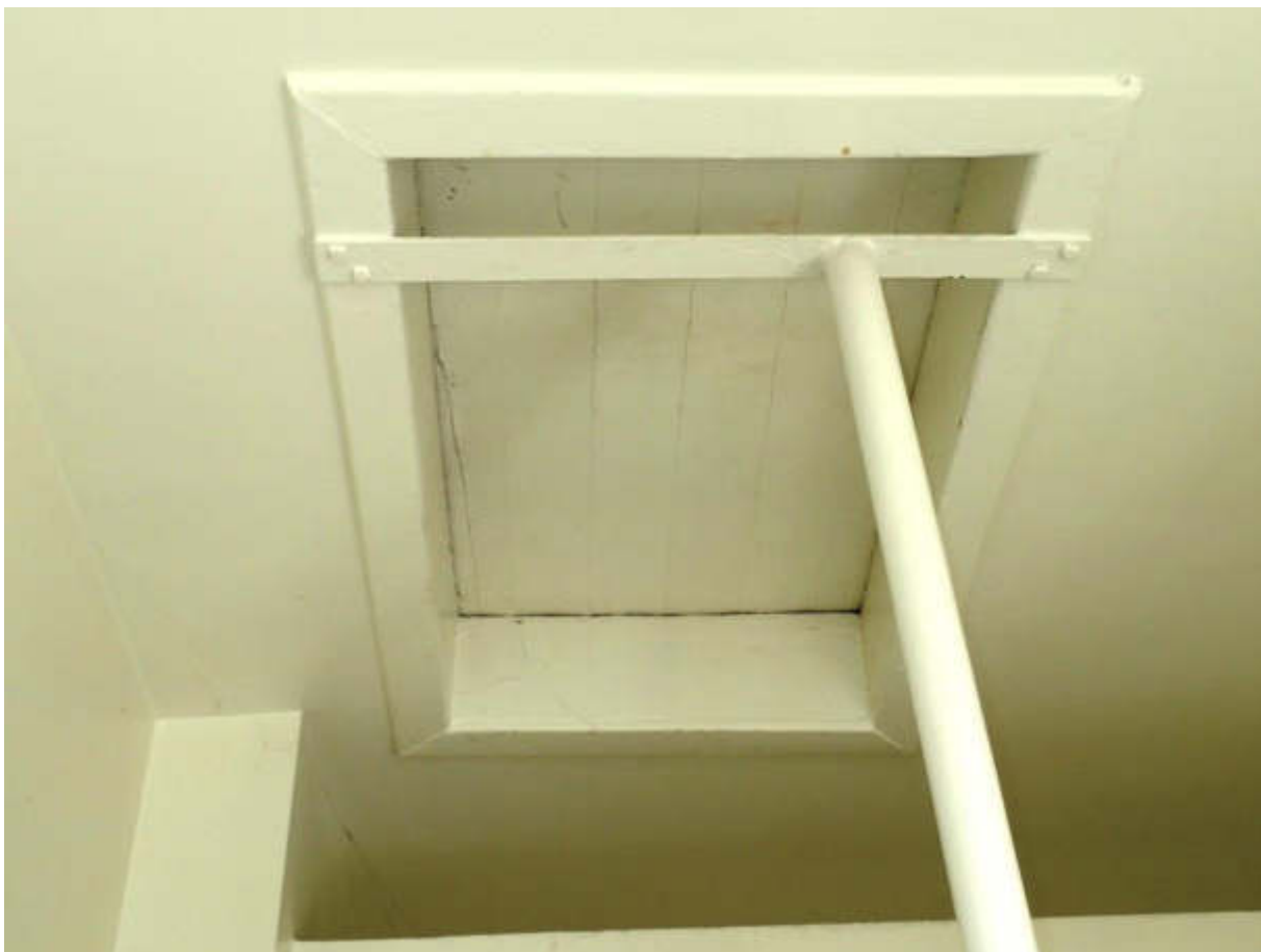
Figur 47 Loftlem på 1. sal af simpel type uden nævneværdig tæthed.
