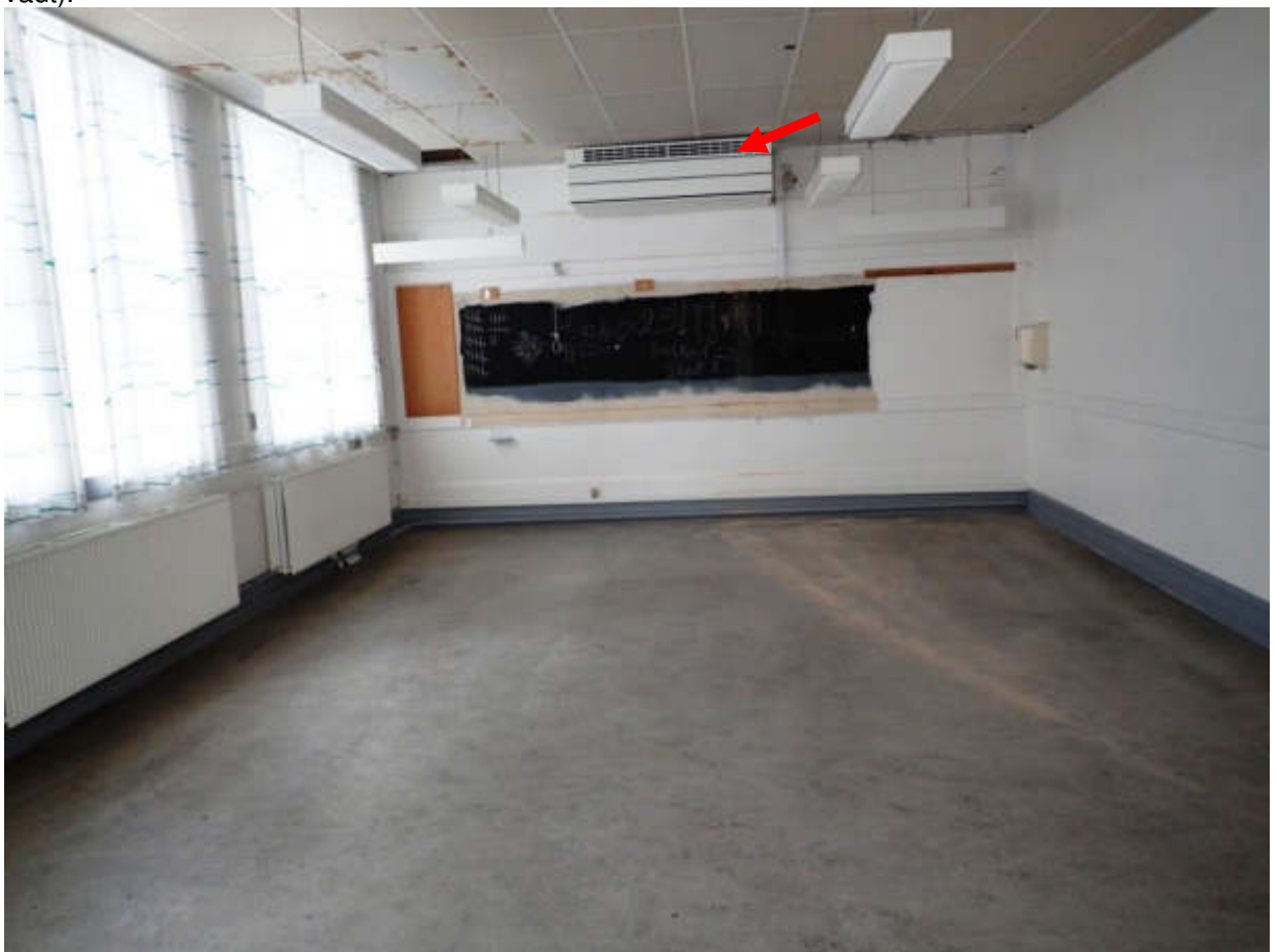
Figur 36 Klasseværelse i stueetagen (mod nordvest). Ventilationsaggregat registreret men ikke afprøvet (rød pil).
