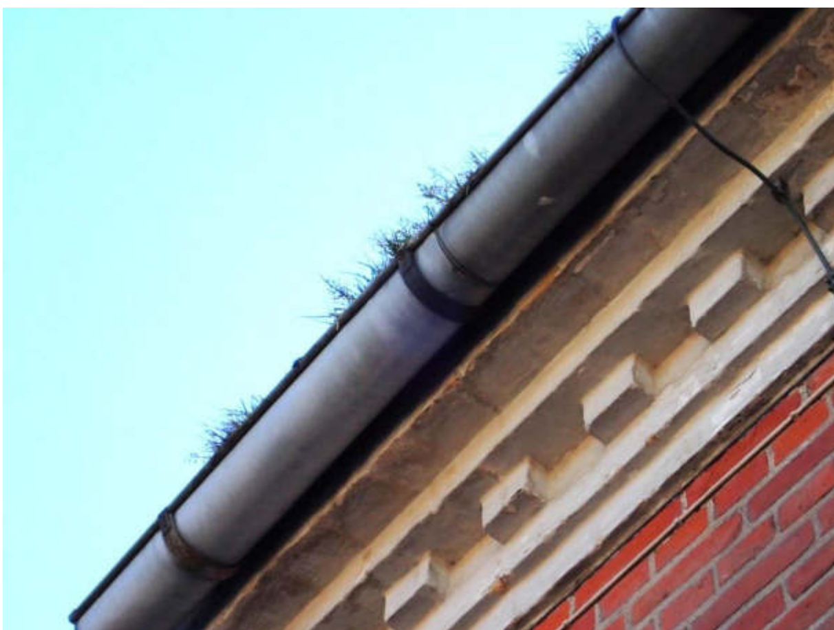
Figur 4 Facade mod nord. Tyndslidte tagrender med bevoksninger.
