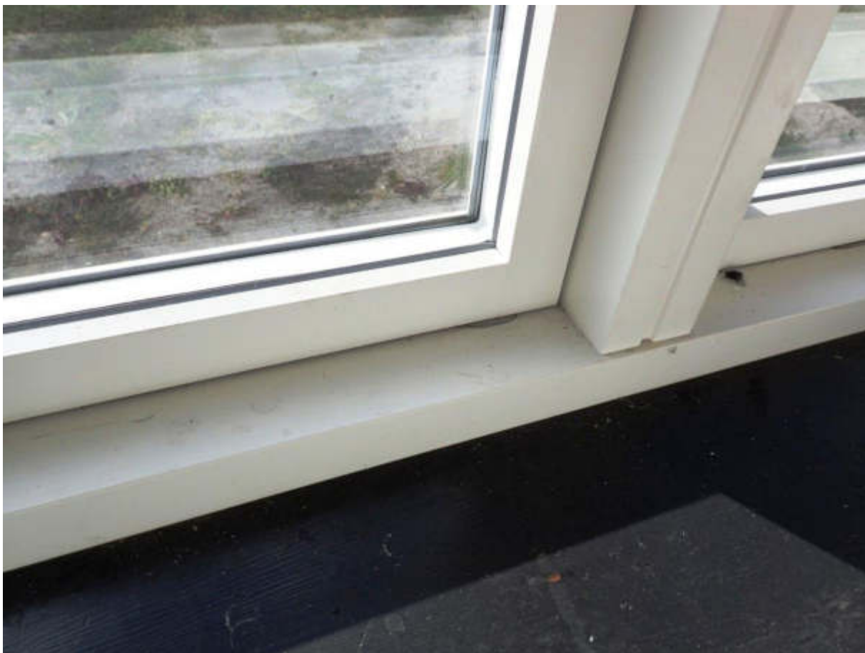
Figur 37 Vinduer mod syd af nyere dato med lavenergiruder.
