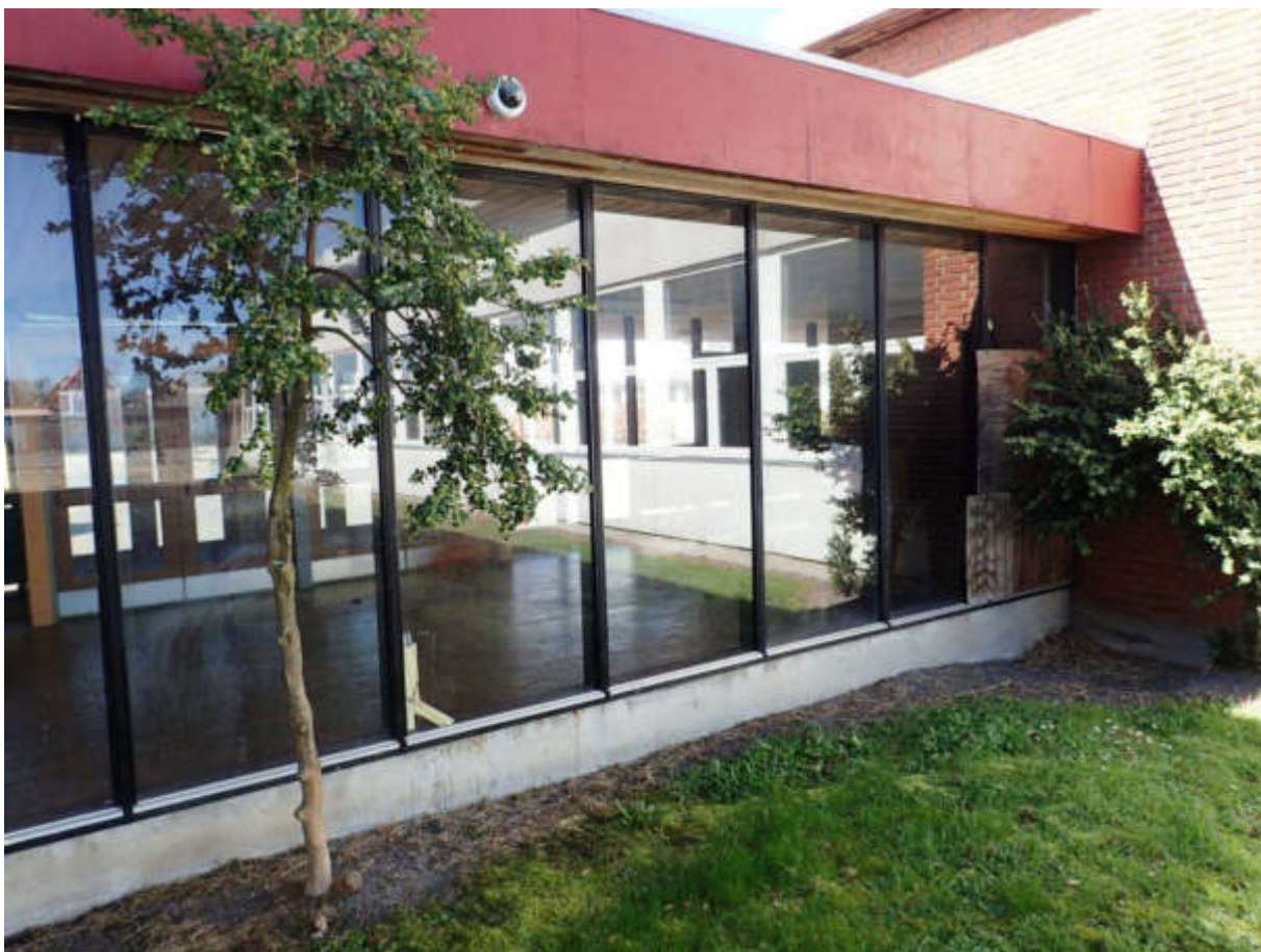
Figur 14 Facade mod øst. Vinduespartier med et lags rude.
