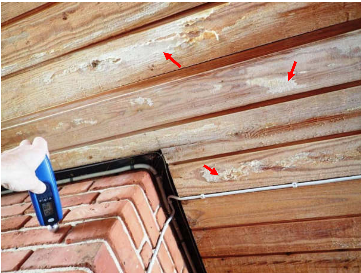
Figur 23 Bygningshjørne på bygning 5. Indikationer på indtrængende nedbør i form af forhøjede fugtniveauer i murværk (ca. 82 ud af 100 digits -vådt) samt, hvad der vurderes at være saltudtrækninger fra imprægnering (røde pile).
