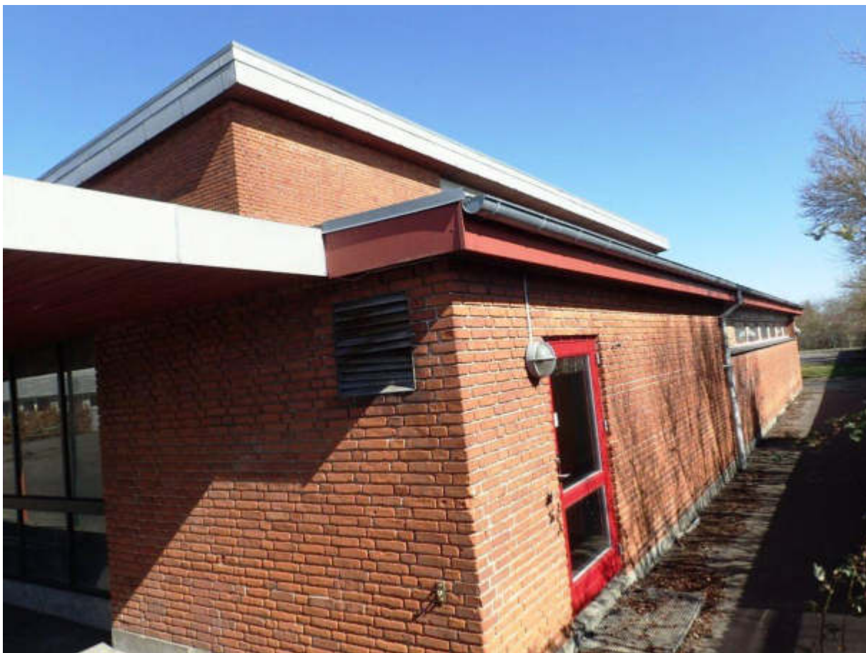
Figur 13 Bygningen set fra sydvest.
