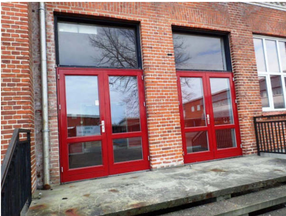
Figur 22 Facade mod øst. Dørpartier (den røde del) af træ-alu af nyere dato.
