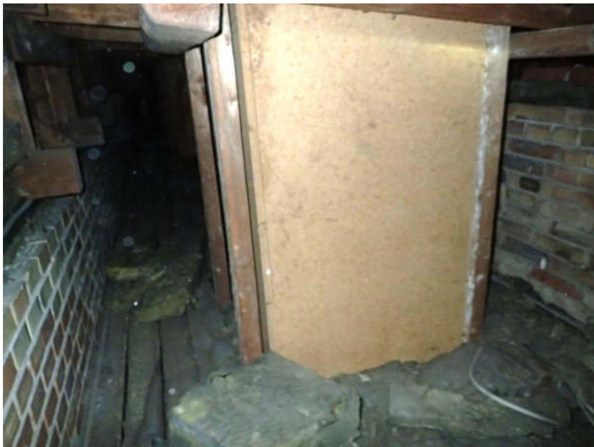
Figur 41 Tagrummet. Lyskasser ved ovenlys af træfiberplader. Ingen varmeisolering eller dampspærre registreret.
