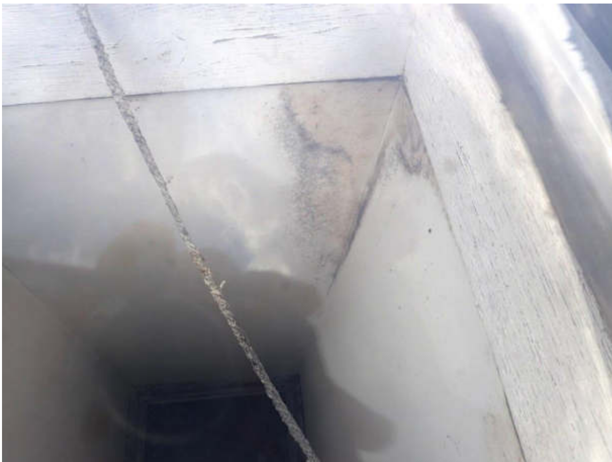
Figur 11 Ovenlyskuppel. Fugtskjolder og synlig skimmelsvamp indikerer indtrængende fugt.
