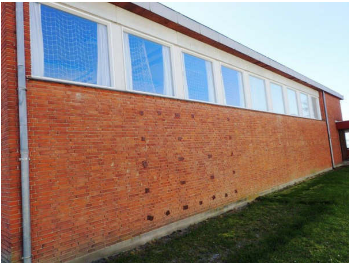
Figur 21 Facade mod nord. Vinduer af nyere dato, vurderingsmæssigt med lavenergiruder.
