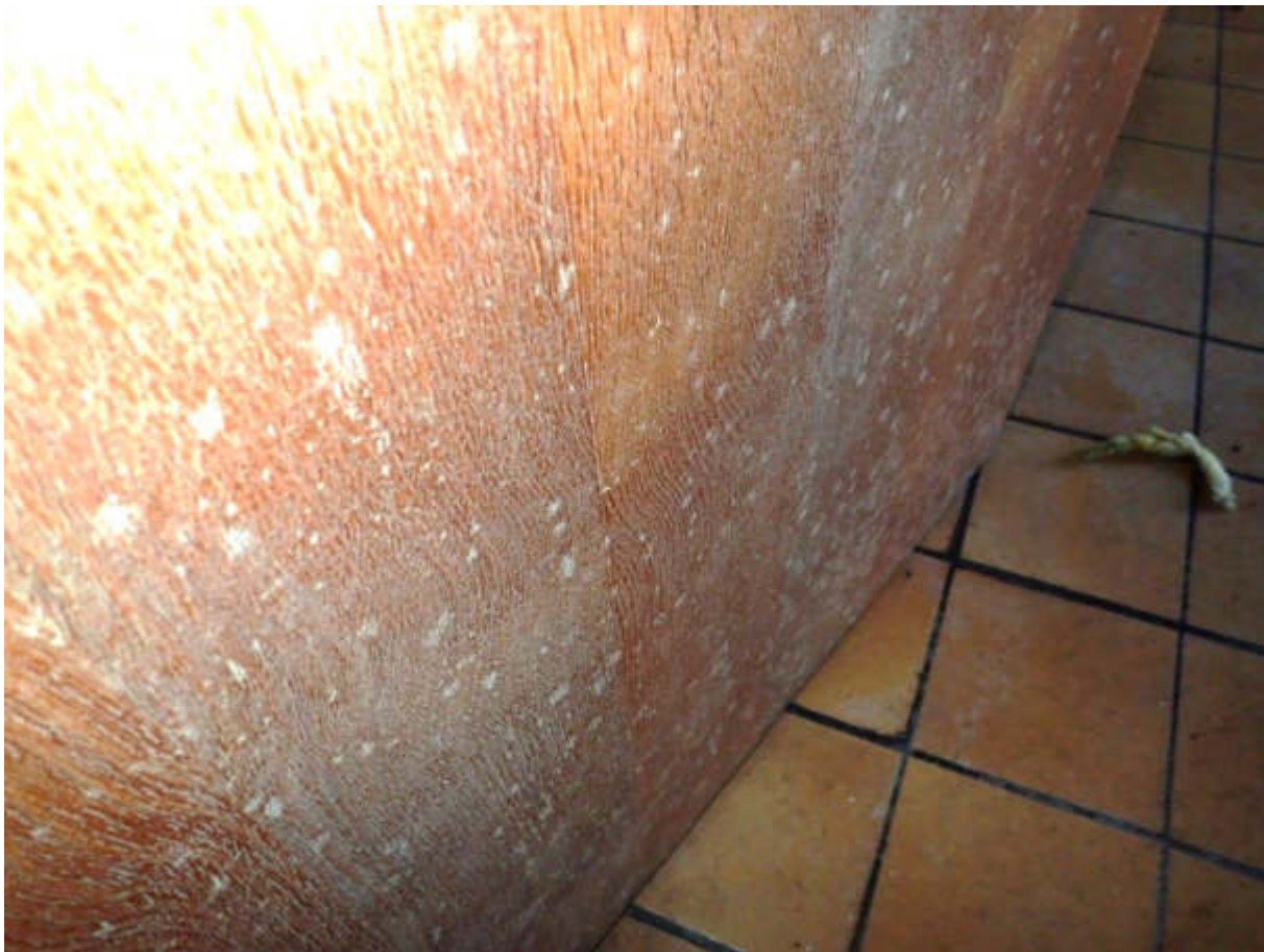
Figur 35 Opfugtede døre med massive synlige forekomster af skimmelsvampevækst.
