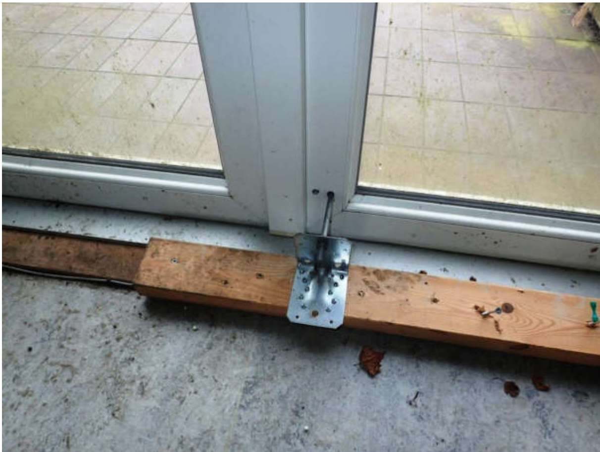
Figur 29 Yderdør i facade mod nord. Dør afblændet med lægte, beslag og stang.
