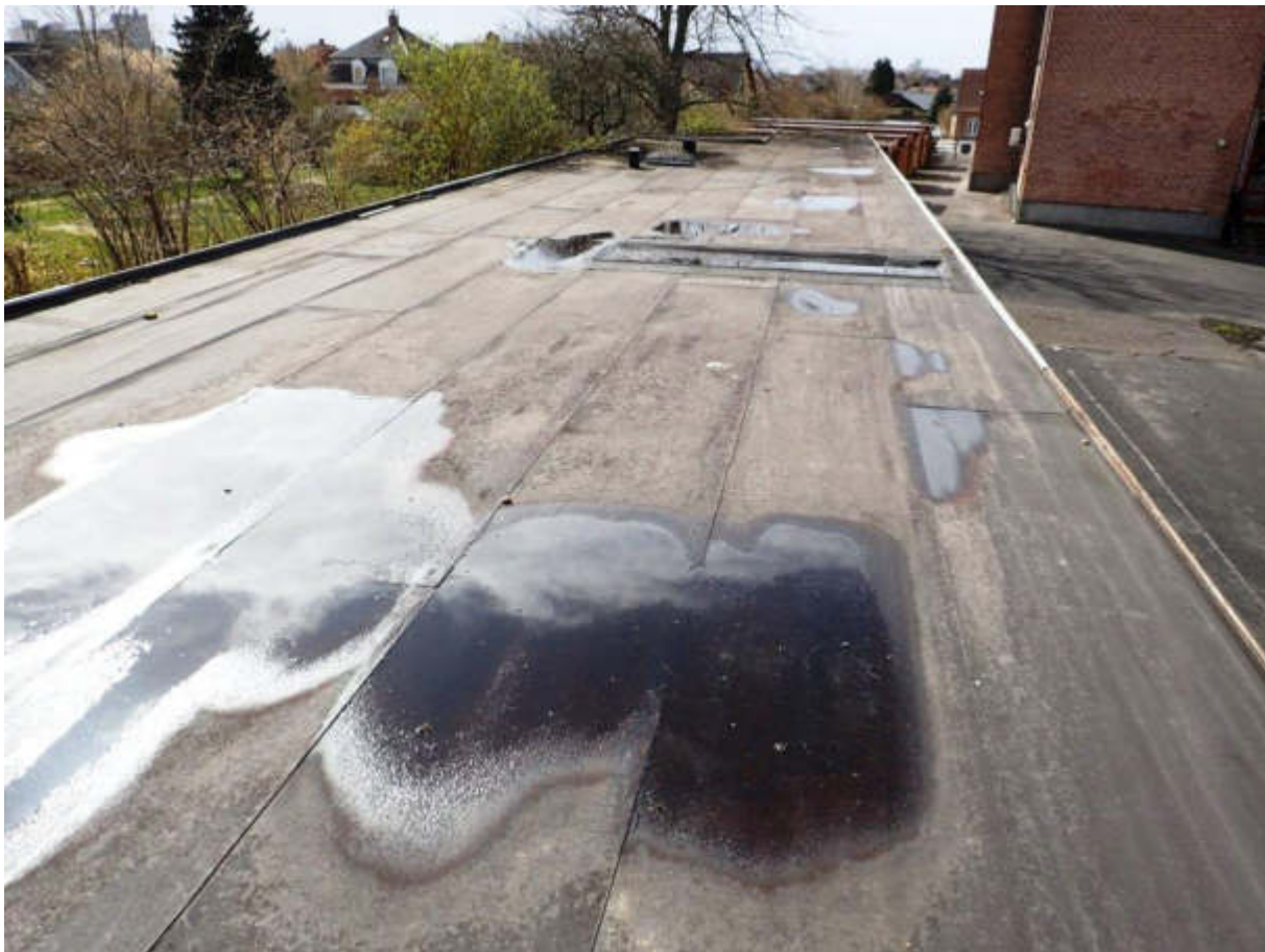
Figur 3 Tagfladen med udtjent tagpap af ældre dato.
