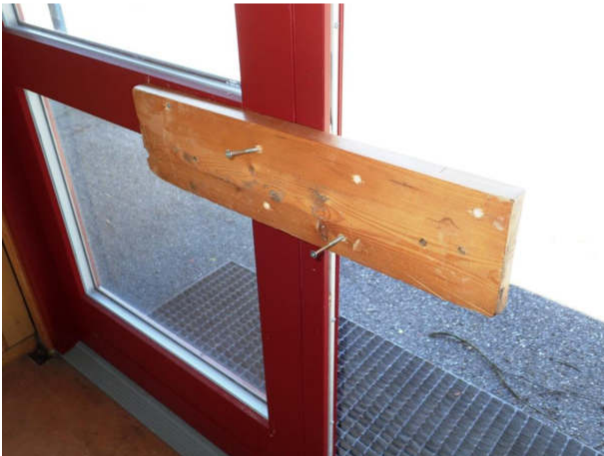
Figur 13 Dør mod skolegården med interimistisk låsemekanisme i form af et bræt med skruer.
