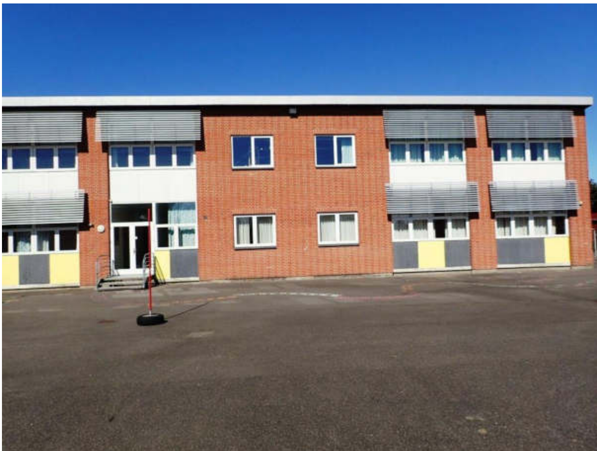
Figur 61 Bygningsfløj med klasseværelser, set fra syd /skolegården mod øst. Denne del er tilbygning fra 1985.
