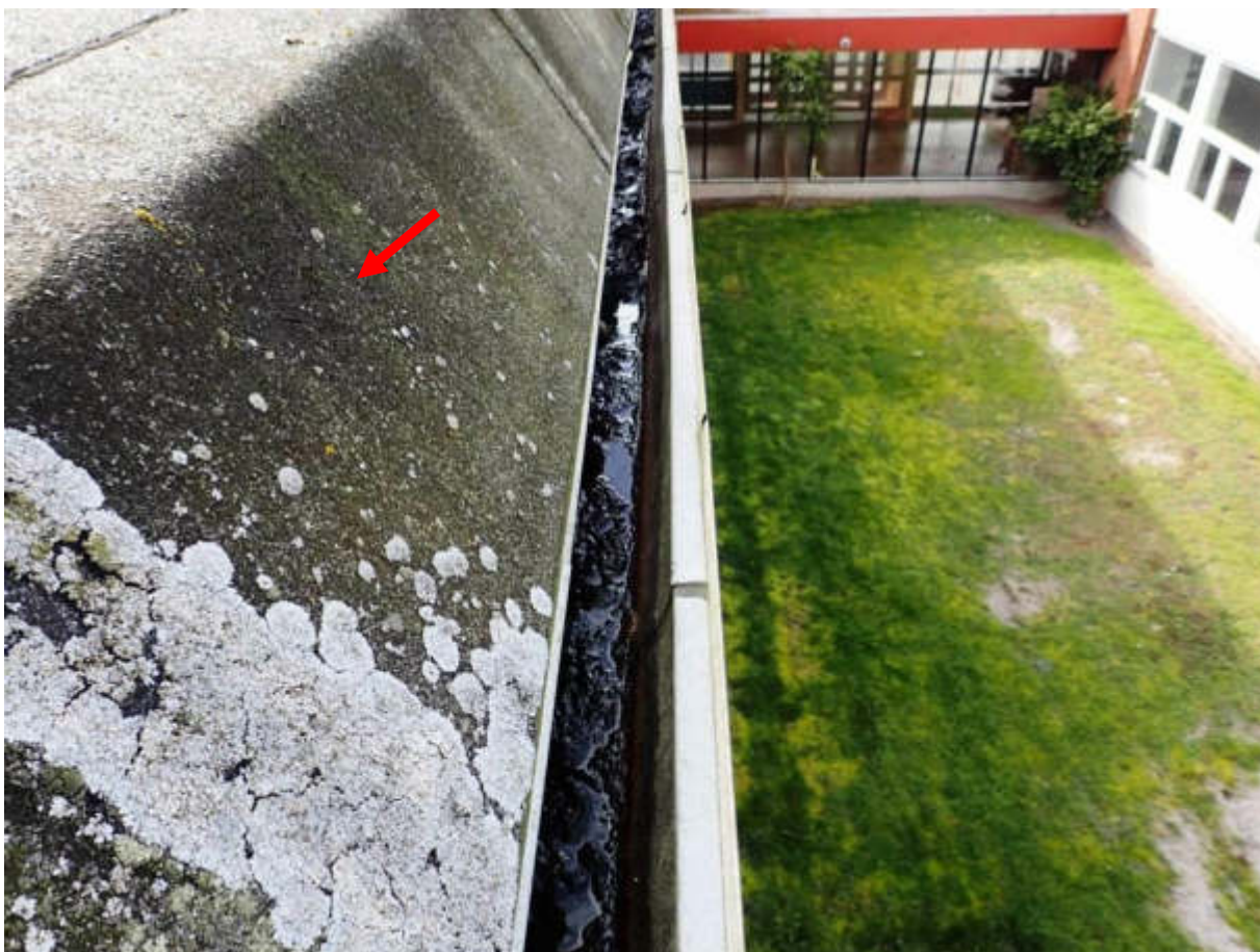
Figur 10 Tagflade over hovedbygning /gymnastiksalen. Forhøjning indikerer at der er etableret udvendig efterisolering /varmt tag (rød pil).
