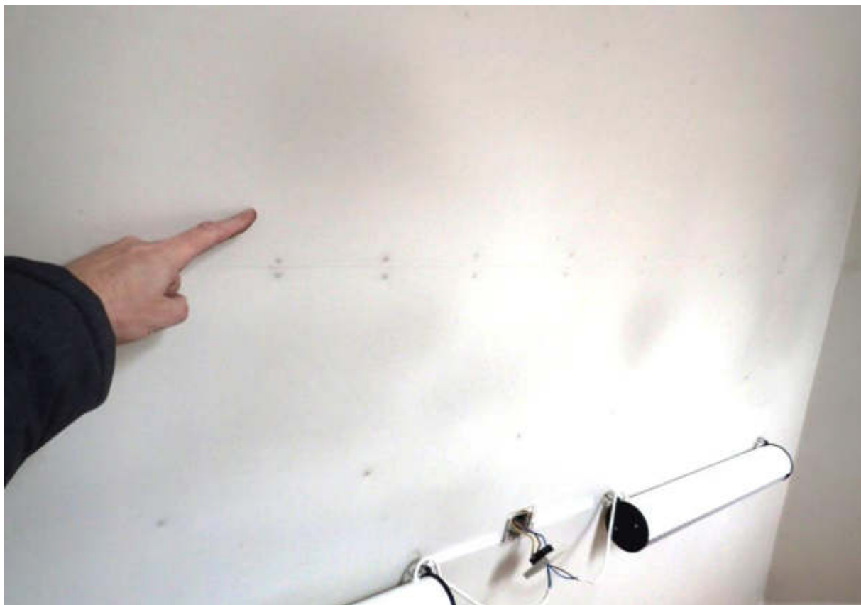
Figur 63 1. sal. Lokale /depotrum mod øst. Støvfigurer /sodsværtning på overflader indikerer ringe varmeisolering. NB: lokalet opvarmes med el-radiator.
