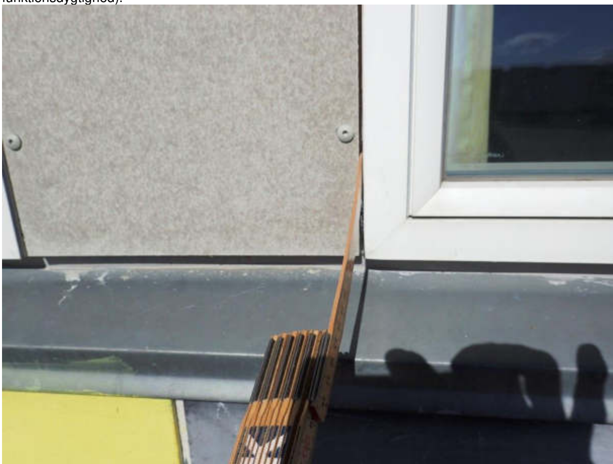
Figur 86 Facade mod syd /skolegården. Åben spalte mellem vinduer og pladebeklædning.
