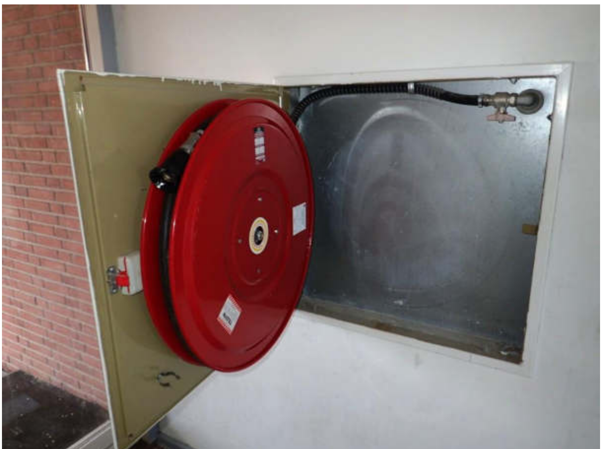
Figur 132 Gangen på 1.sal. Der blev ikke registreret forhold, der indikerede at slangevindere ikke var funktionsdygtige.
