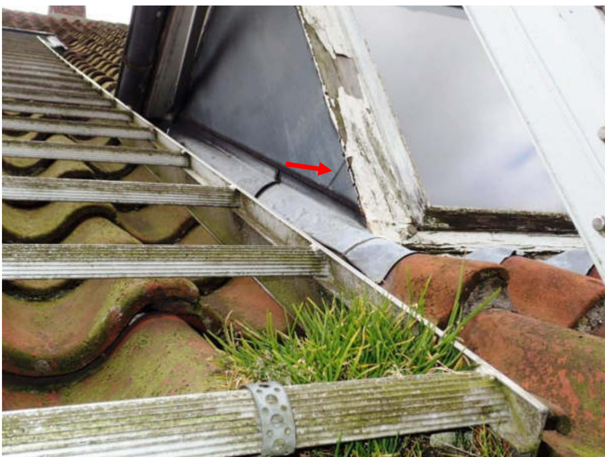
Figur 6 Facade mod nord. Bevoksninger i tagrende samt løst zinkbeklædning på kvist (rød pil). Tvivlsom funktion og begyndende forfald.
