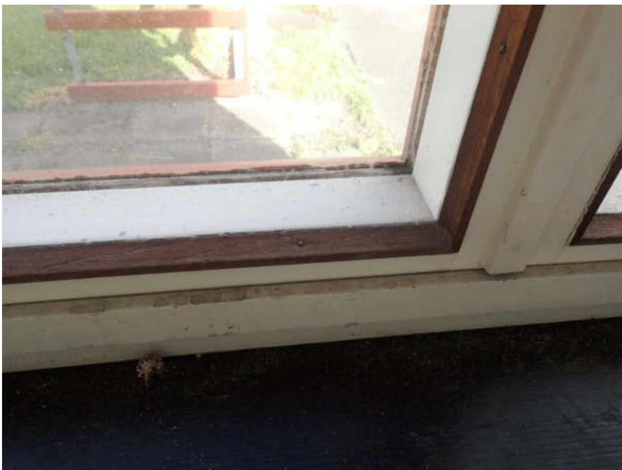
Figur 36 Vinduer mod nord af ældre dato med koblede rammer.
