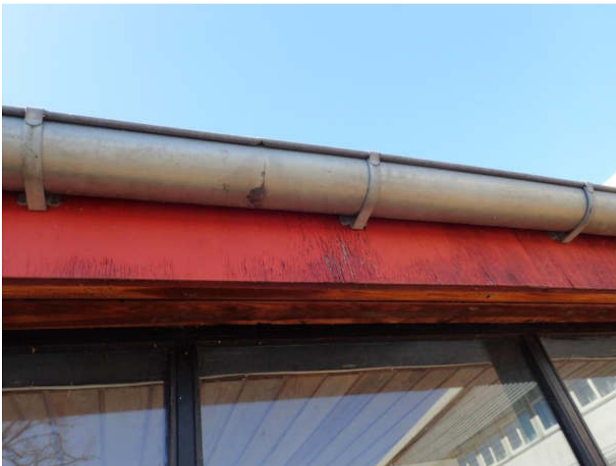
Figur 11 Mellembygning med kontorer. Facade mod øst. Udhæng af træ med ringe vedligehold.
