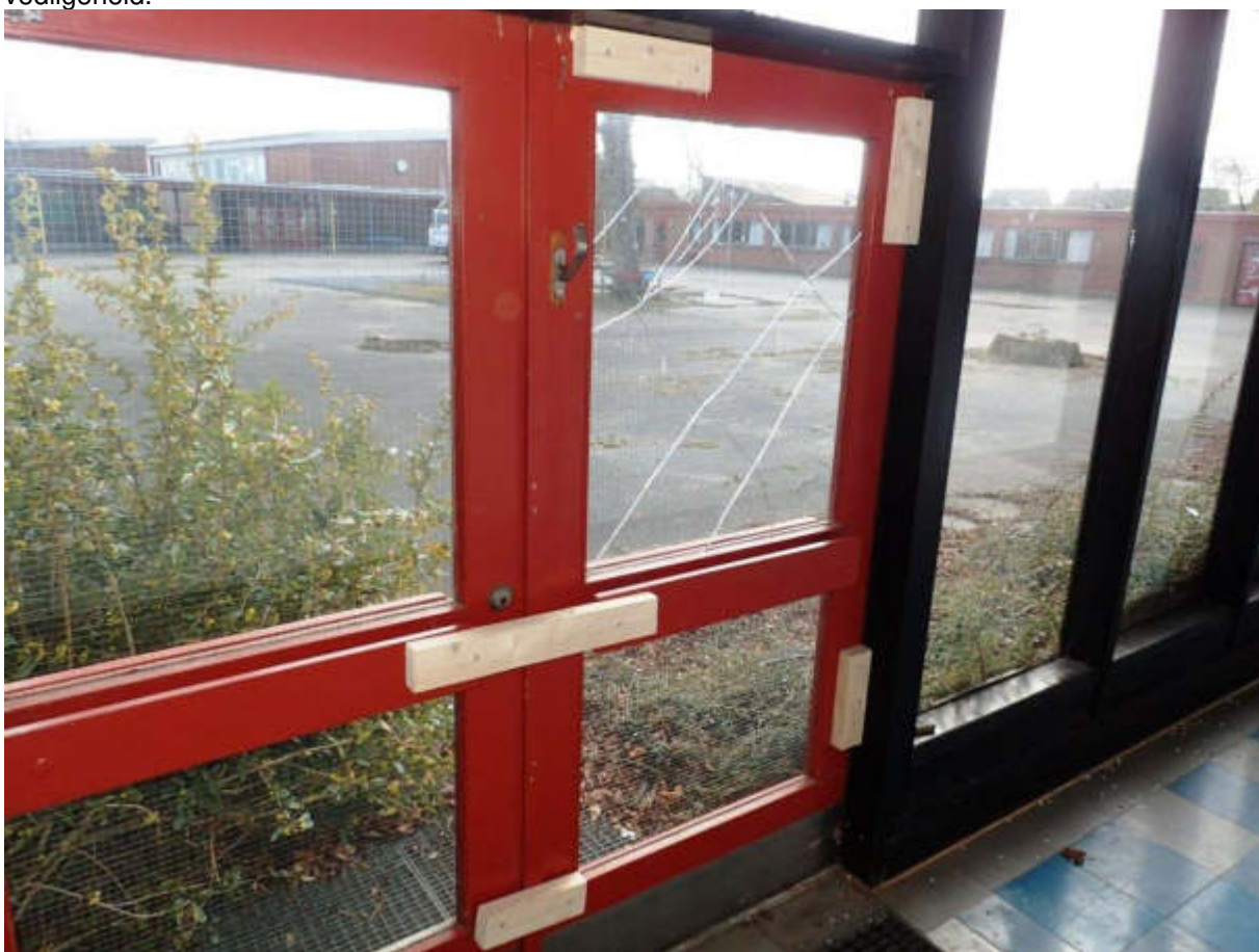
Figur 14 Mellembygning med kontorer. Dør blokeret med smadret rude og påskruede lægter.
