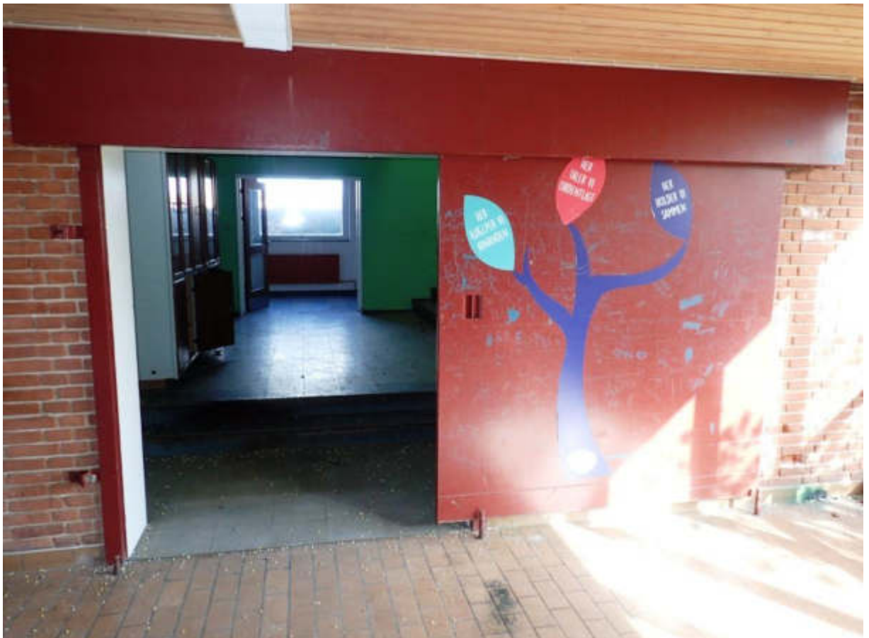
Figur 17 Adskillende dør mod bygning 3. Rulledør af metal af ældre dato. Funktion blev ikke afprøvet.
