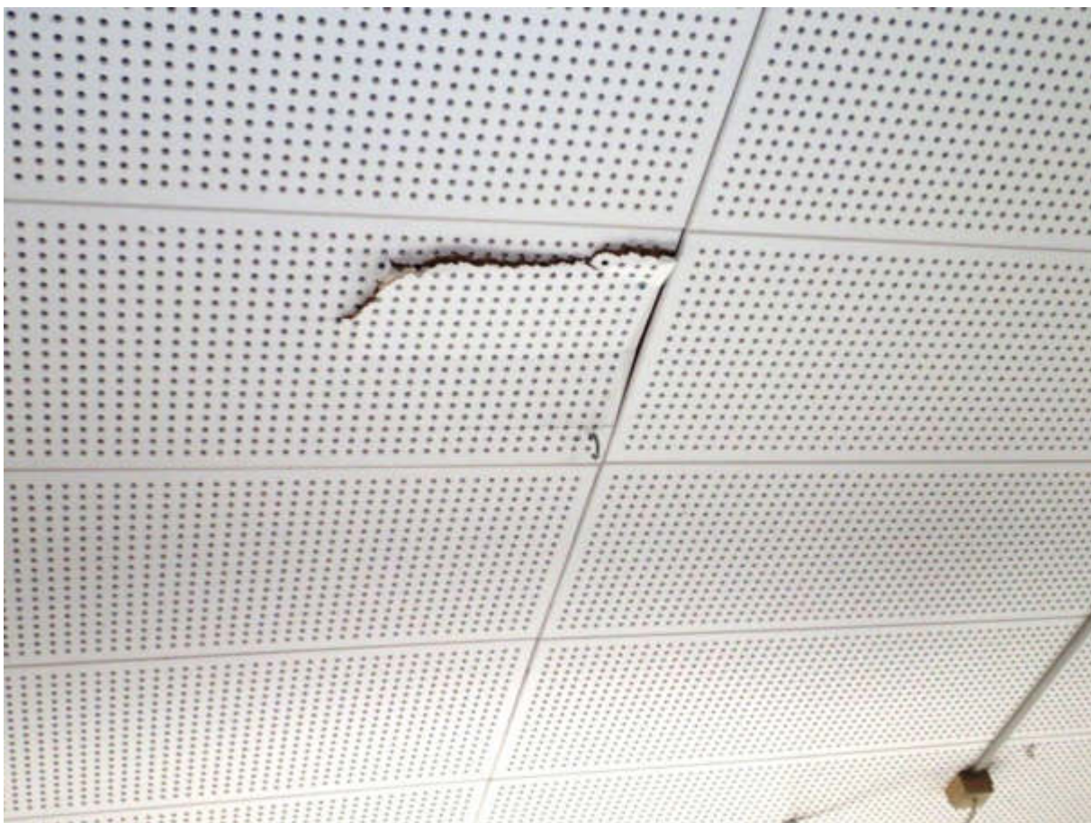
Figur 122 Stueetagen. Loftplader med skader.
