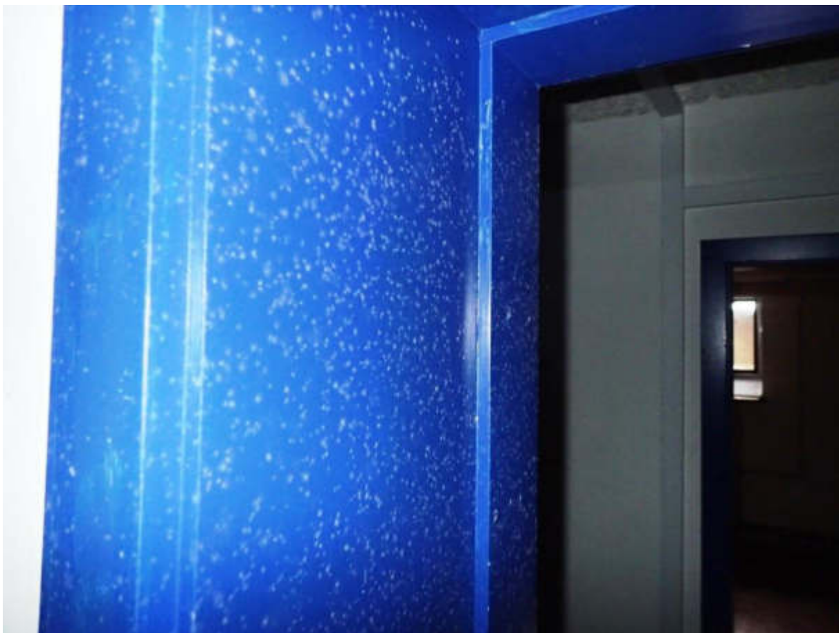
Figur 55 Kælderen. Synlige forekomster af skimmelsvampevækst på træværk, her på dørkarm.
