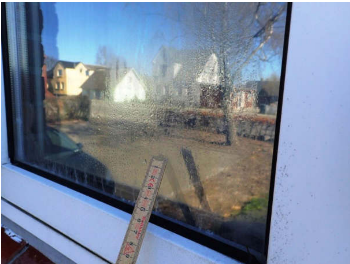
Figur 21 Facade mod vest. Vindue med punkteret rude.
