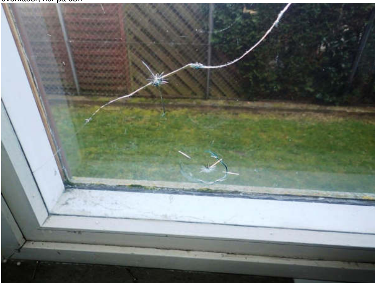
Figur 100 Gangen i stueplan. Vindue med skadet rude.
