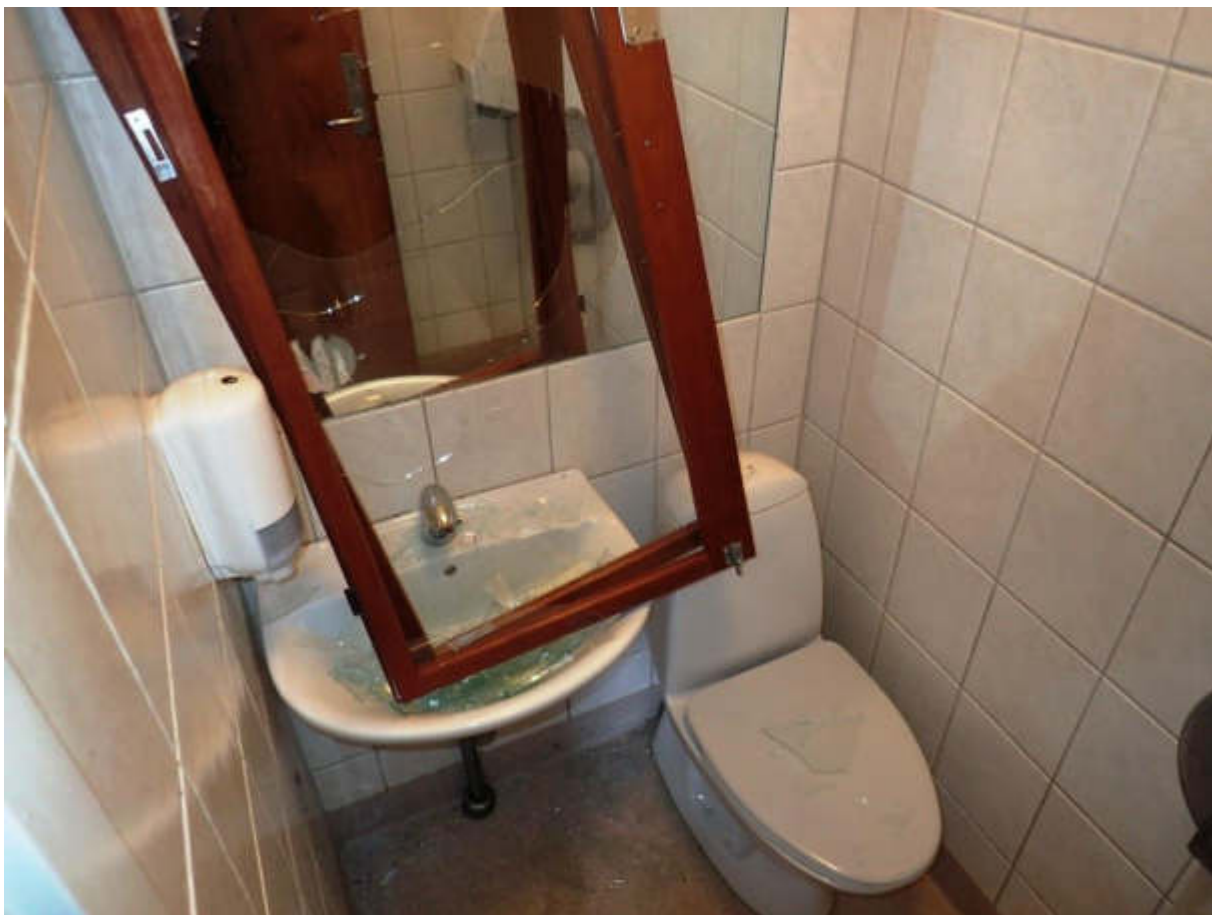
Figur 109 Toilet stueplan. Ramme med smadret rude og glasskår.
