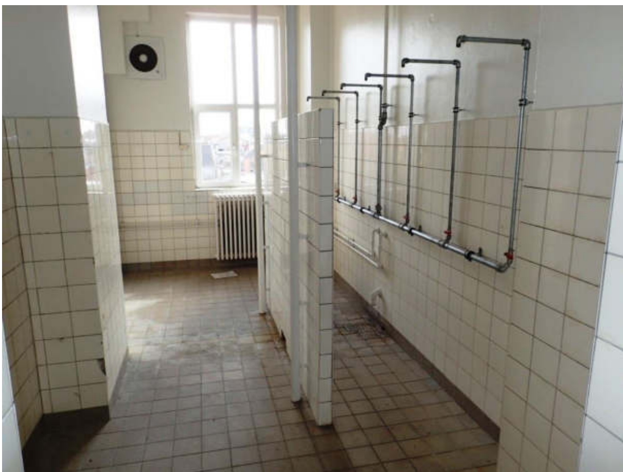
Figur 46 Baderum på 1. sal. Hvorvidt vådzone var tidssvarende tæt var ikke muligt at klarlægge.
