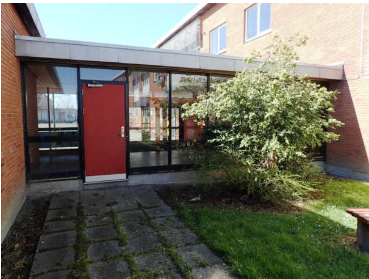
Figur 16 Facade mod øst- Vinduespartier med et lags rude.
