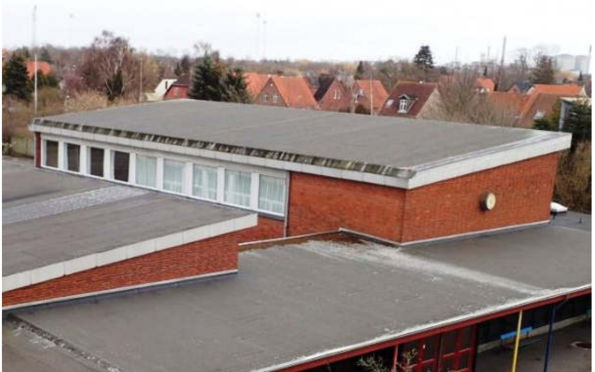
Figur 1 Bygningen set fra nordvest.
