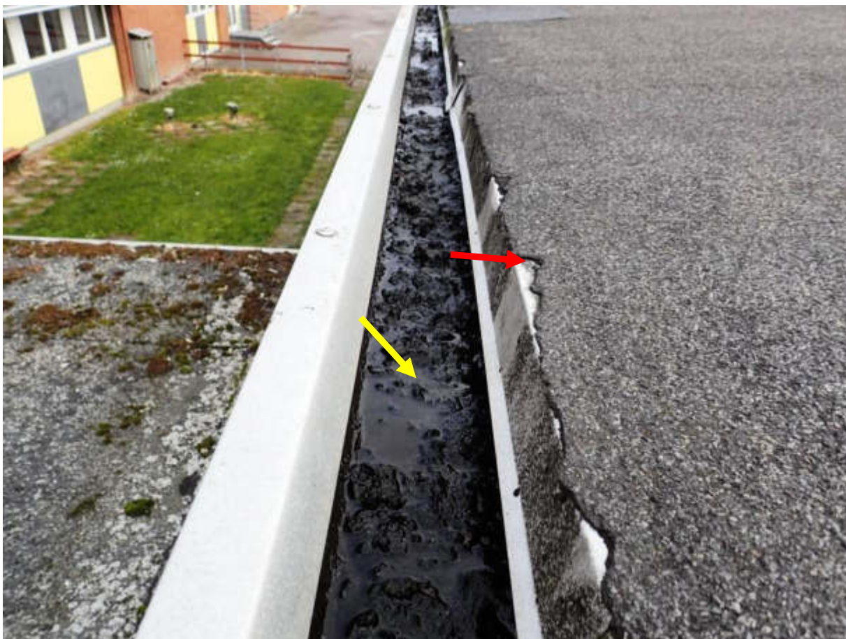
Figur 5 Tagfladen. Flosset og udtjent tagpap (rød pil). Bemærk tagrende fyldt med skidt (gul pil).
