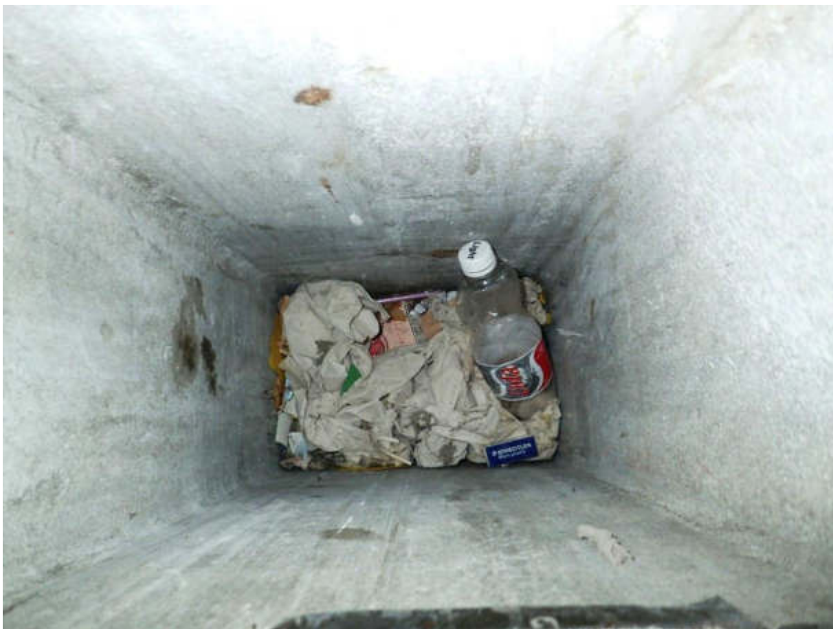
Figur 105 Klasseværelse 13. Rist i væg manglede og der var åbent ind i skakt i væg. Skakt var tilstoppet og delvist fyldt med affald.
