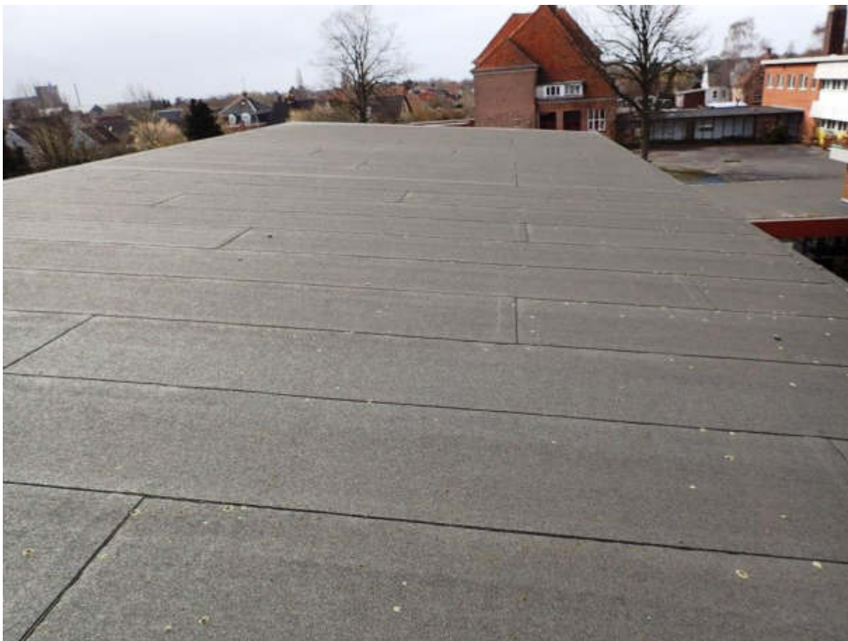
Figur 9 Tagflade over hovedbygning /gymnastiksalen. Tagpap af nyere dato.
