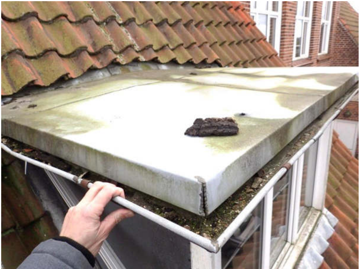
Figur 7 Tagflade mod nord. Zink af ældre dato med begrænset restlevetid.
