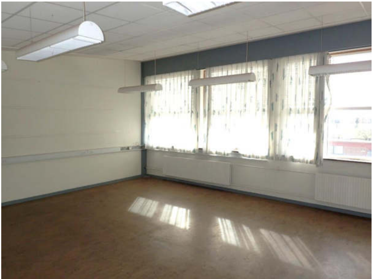
Figur 143 Klasseværelse 21. Vinduer af nyere dato. Gulvbelægning med slidte overflader.
