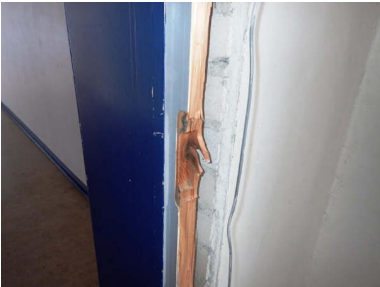
Figur 117 Gangen. Flækket dørkarm.
