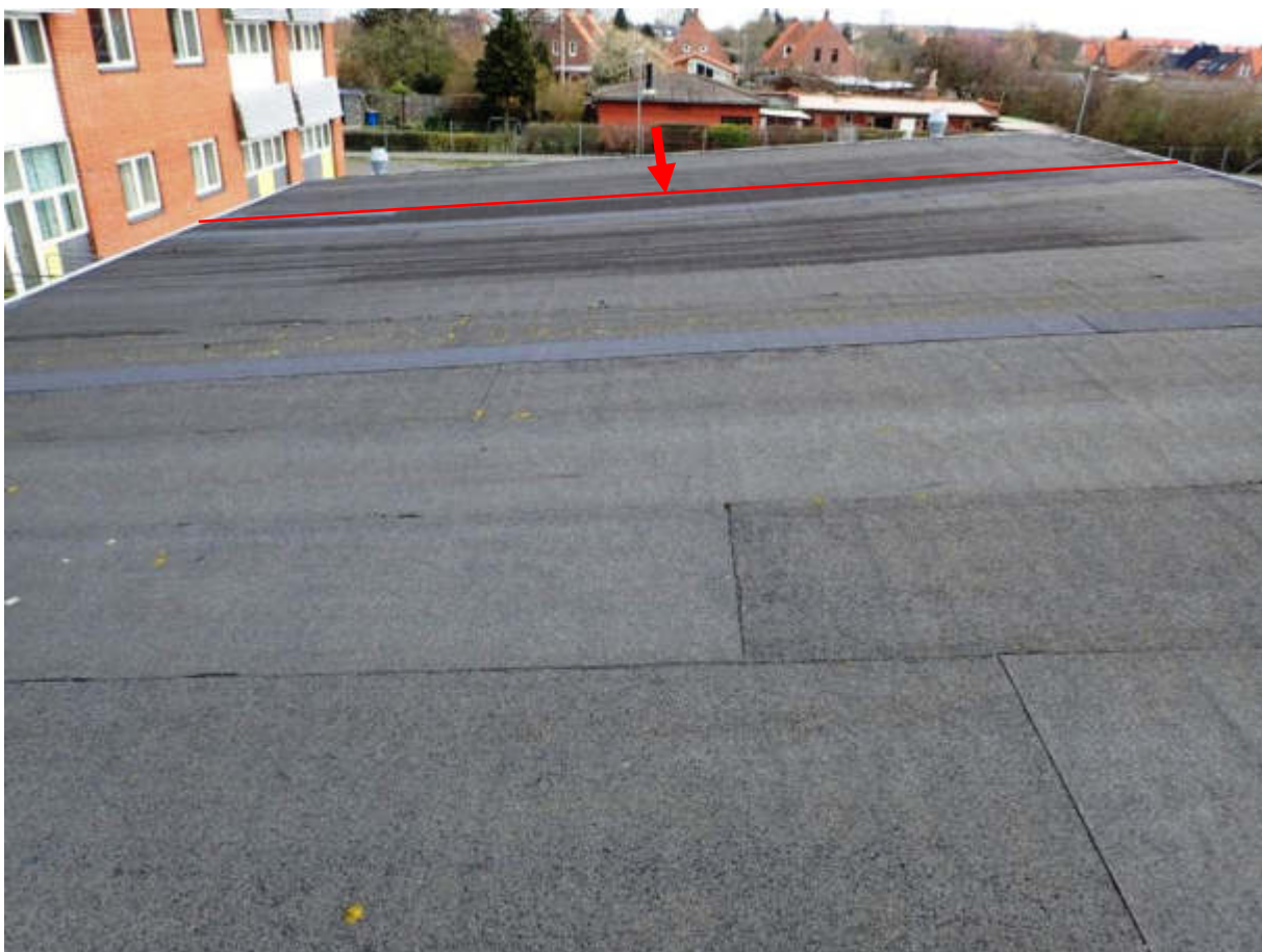
Figur 4 Tagfladen. Udtjent tagpap af ældre dato. Bemærk tagkonstruktion buer ned (rød pil).
