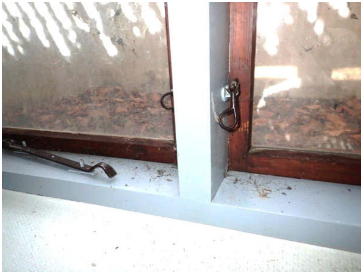
Figur 59 Kældervinduer med et lags ruder.
