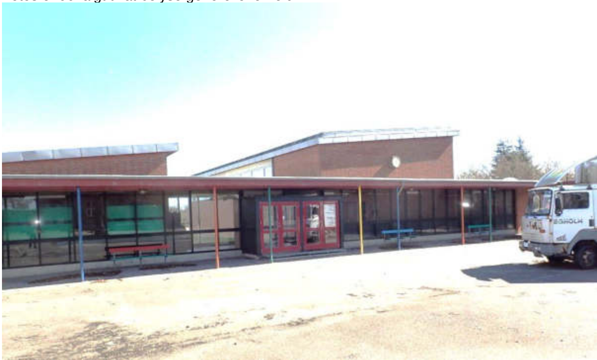
Figur 1 Bygningen set fra vest /skolegården.
