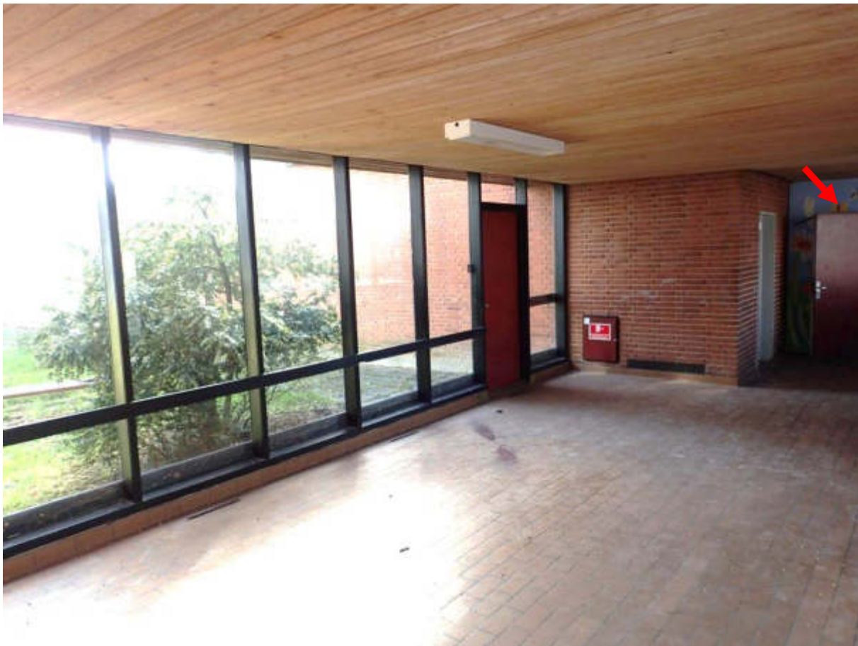
Figur 19 Vinduesparti mod øst med et lags rude. DNA-prøven blev udtaget på dør ved rød pil.
