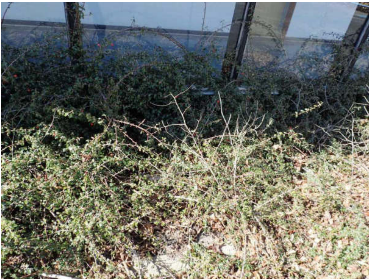
Figur 9 Mellemlbygning med kontorer. Facade mod øst. Bevoksninger tæt op ad vinduespartier.
