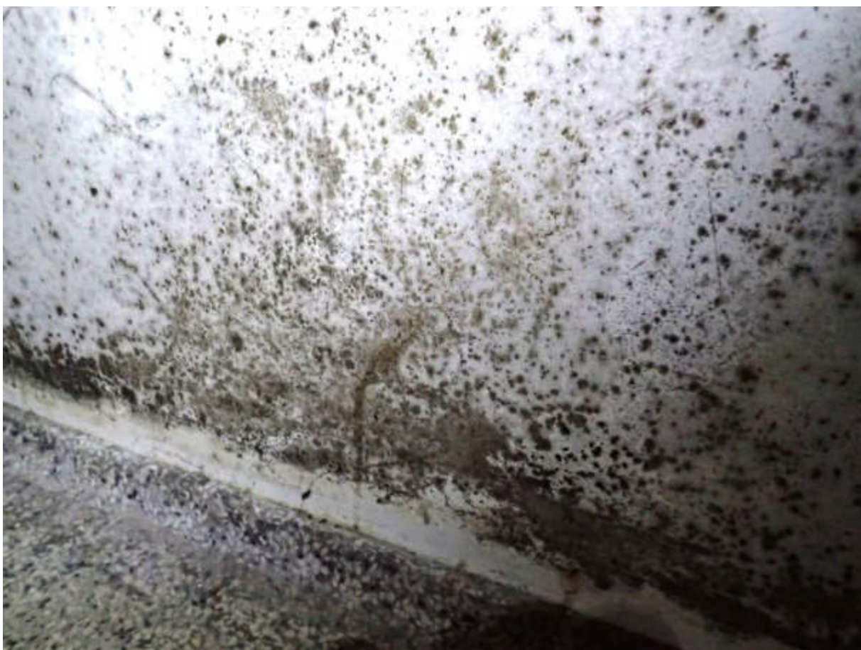
Figur 58 Kælderen. Synlige forekomster af skimmelsvampevækst på ydervæg.
