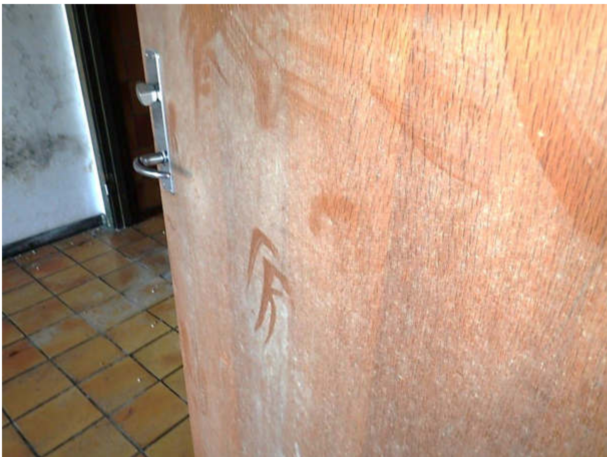
Figur 34 Opfugtede døre med massive synlige forekomster af skimmelsvampevækst.
